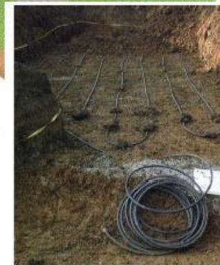
Horizontalni zemeljski kolektor
